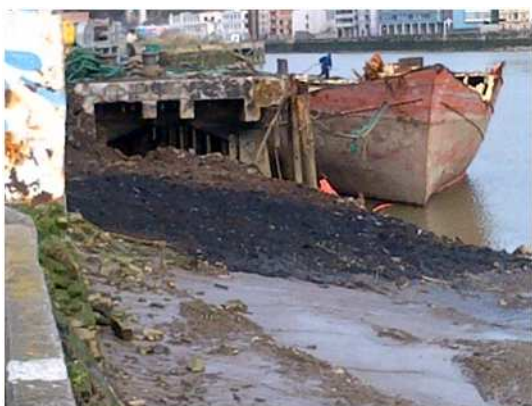
Detalle del material geológico existente en la zona de ribera
