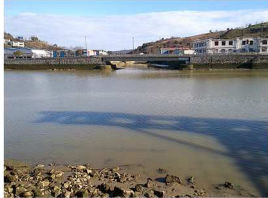
Vista de la zona Este del Plan, colindante con la ría del Nerbioi-Ibaizabal
