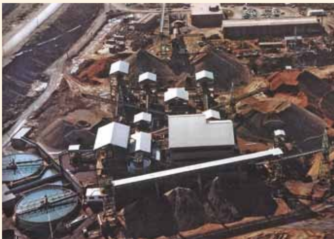
Planta de concentración de Bodovalle
