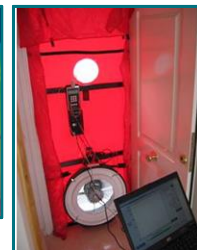
Blower door test
