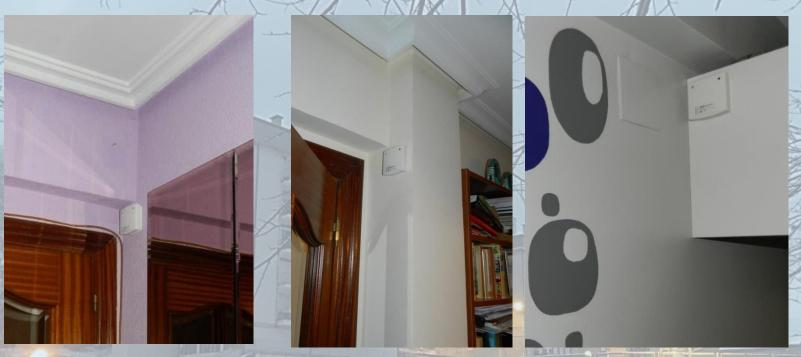
Termohigrómetro (Temperatura y humedad en un solo medidor) en salones de viviendas, autoalimentados con pilas, transmitiendo en frecuencia radio (868,3 MHz).
