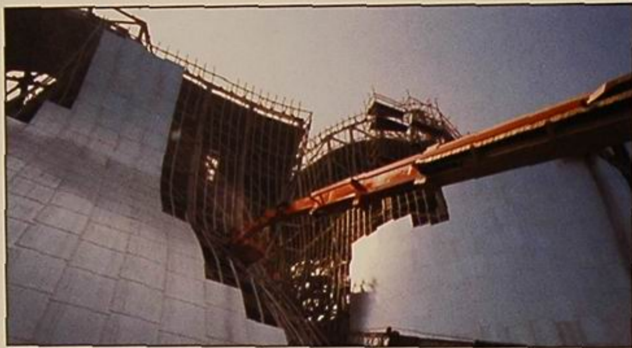
Las obras de construcción avanzan a buen ritmo y el espectacular museo será inaugurado en junio del 97
